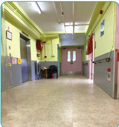
▲樓層翻新工程
